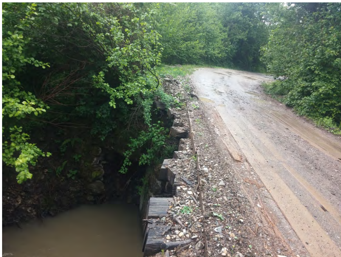
Slika broj: 44. Izgled mosta sa drvenim talpama
