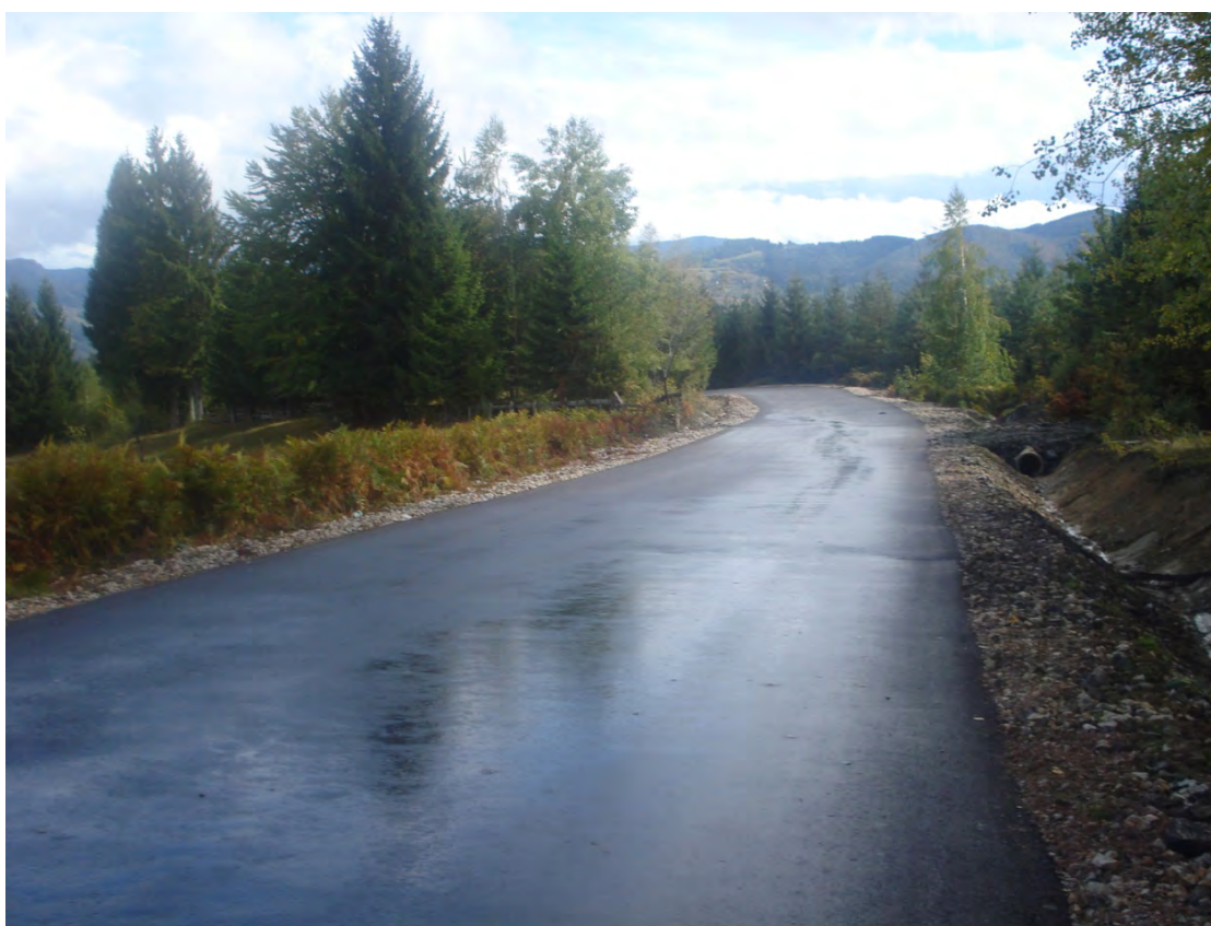
Slika broj: 19. Novi asfalt na dionici Šimin Potok-Podkamensko
