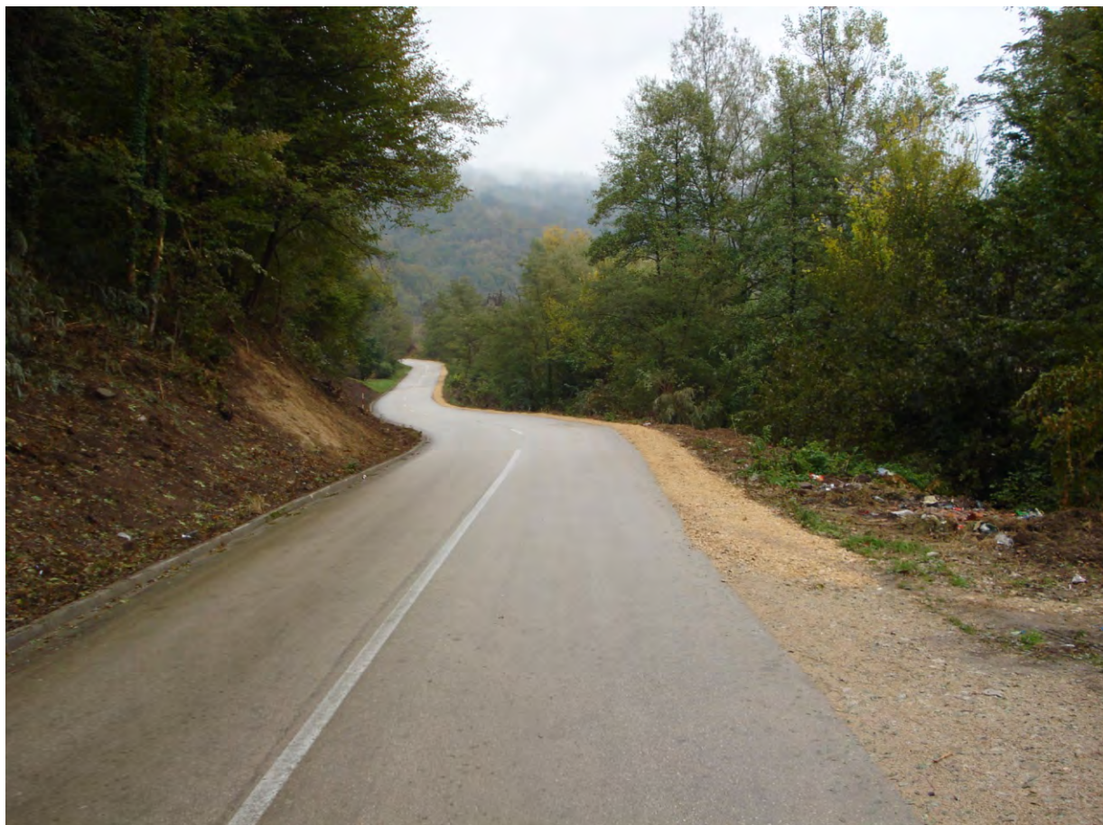
Slika broj: 38. Rekonstruisana dionica ceste Zavidovići - Maglaj
