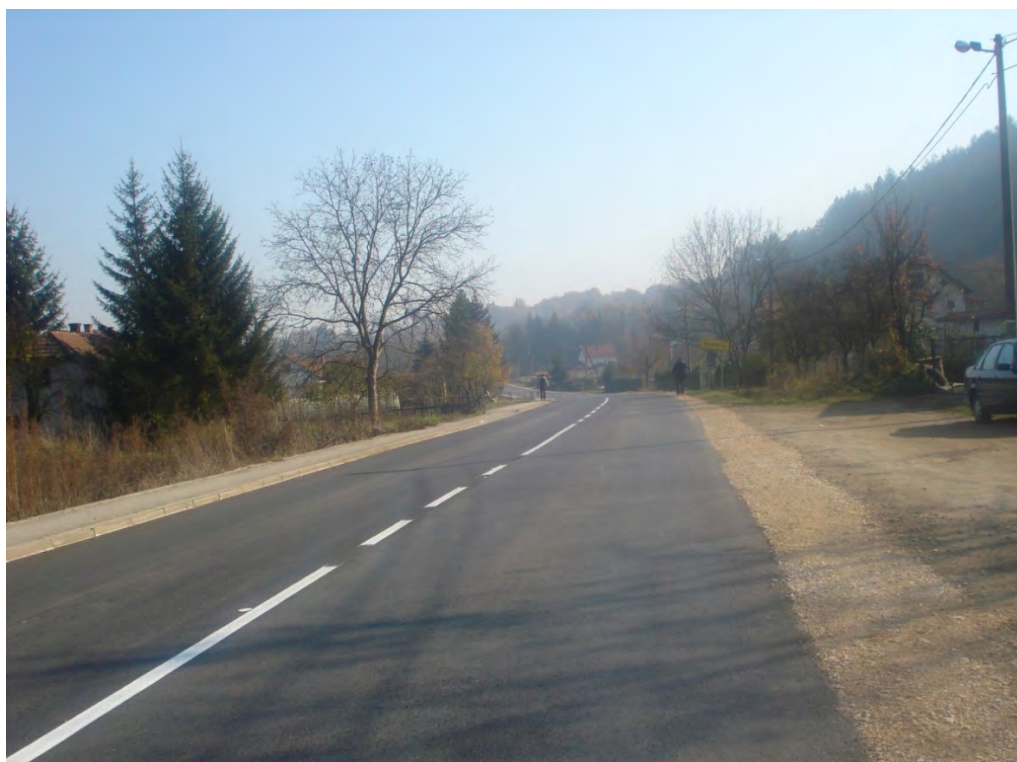
Slika broj: 37. Rekonstruisana dionica ceste Žepče - Zavidovići
