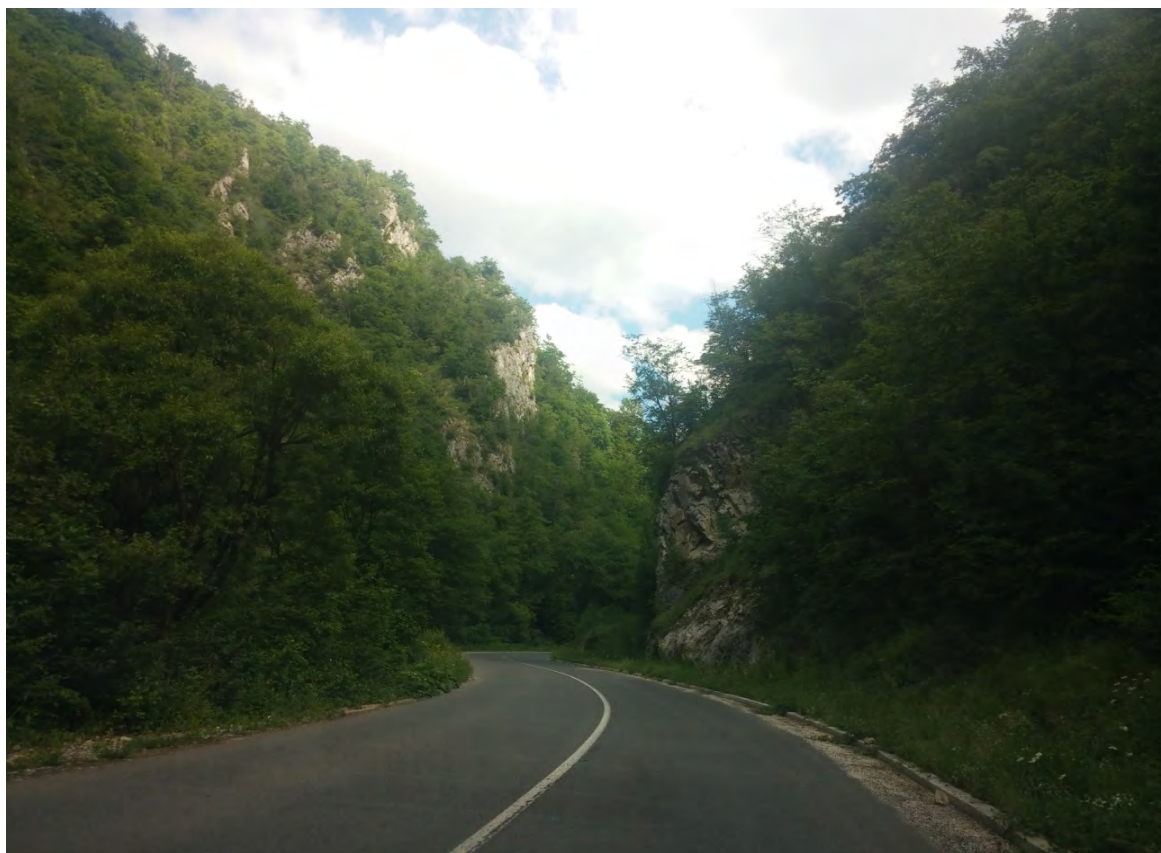
Slika broj: 14. Dionica rekonstruisane ceste
