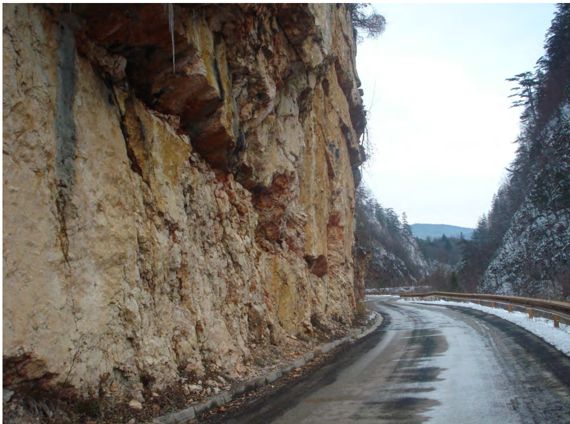
Slika broj: 58. Izgled ceste u zasjeku
