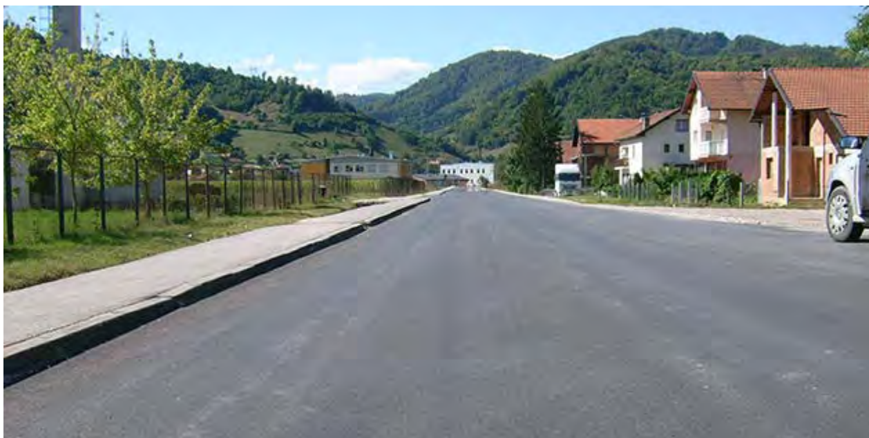
Slika broj: 35. Rekonstruisani dio saobraćajnice
