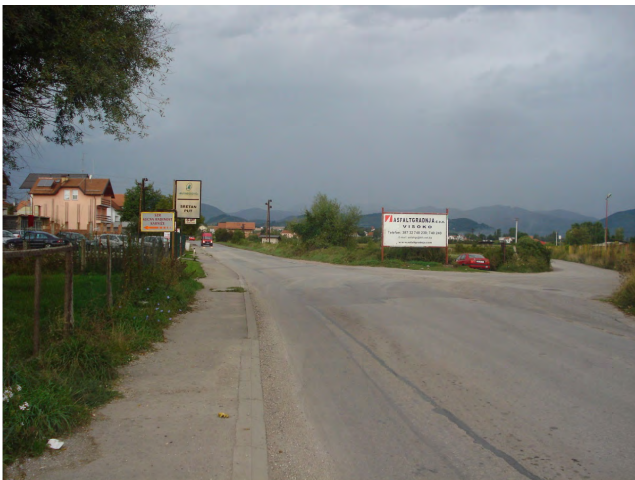
Slika broj: 36. Dionica regionalne ceste Kakanj - Visoko
