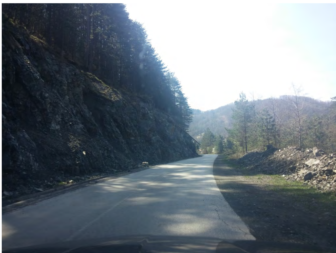
Slika broj: 50. Dionica Zavidovići - Ribnica
