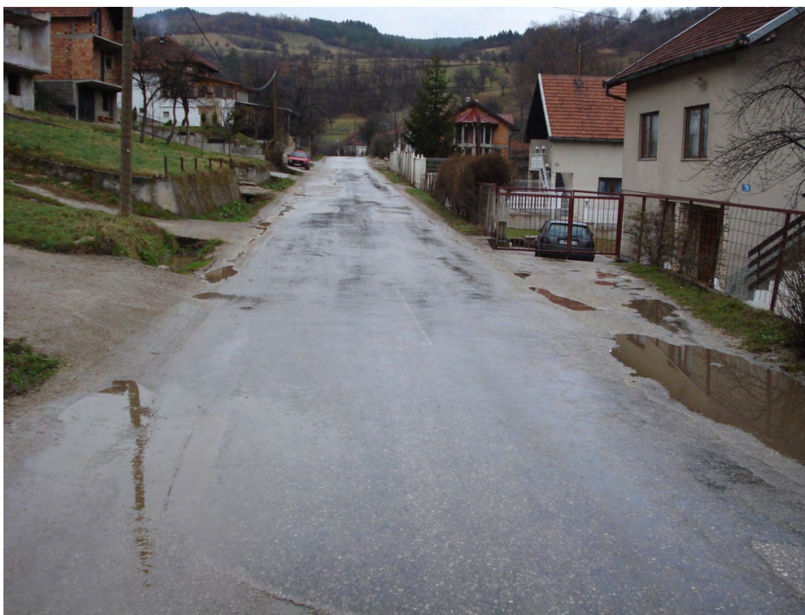
Slika broj 1. Uzan kolovoz i neriješena odvodnja
