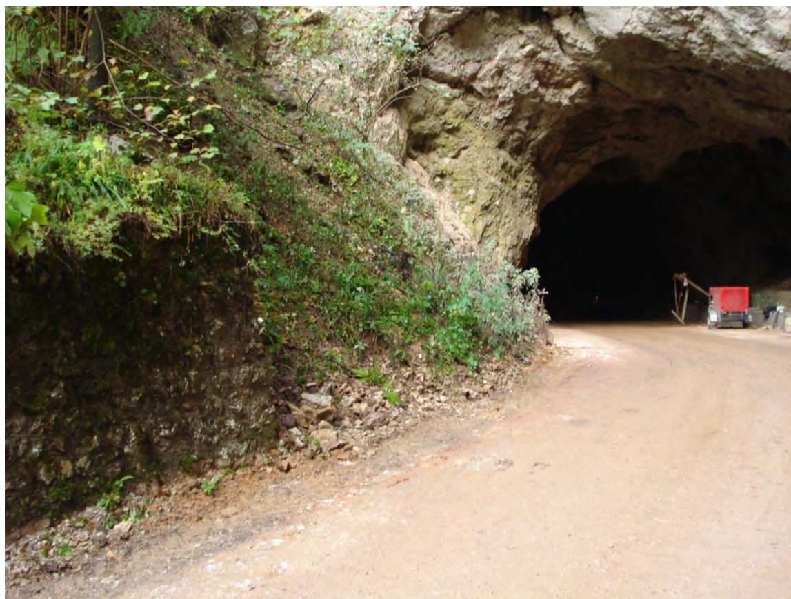
Slika broj: 17. Tunel „Ponikve“
