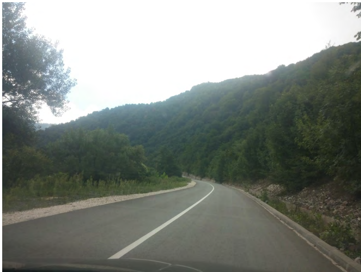
Slika broj: 28. Novi asfaltni kolovoz Nemila-Vranduk
