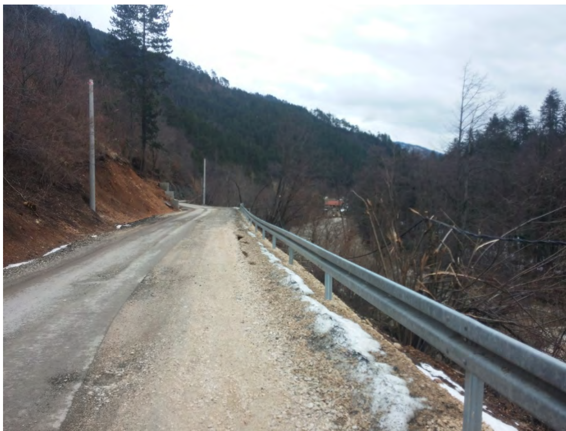
Slika broj: 52. Sanirano klizište na dionici Ribnica - Olovo
