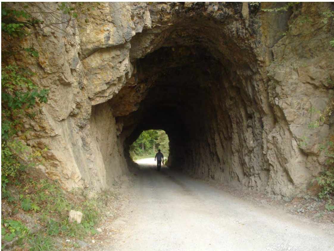
Slika broj: 60. Tunel „Petrovići“
