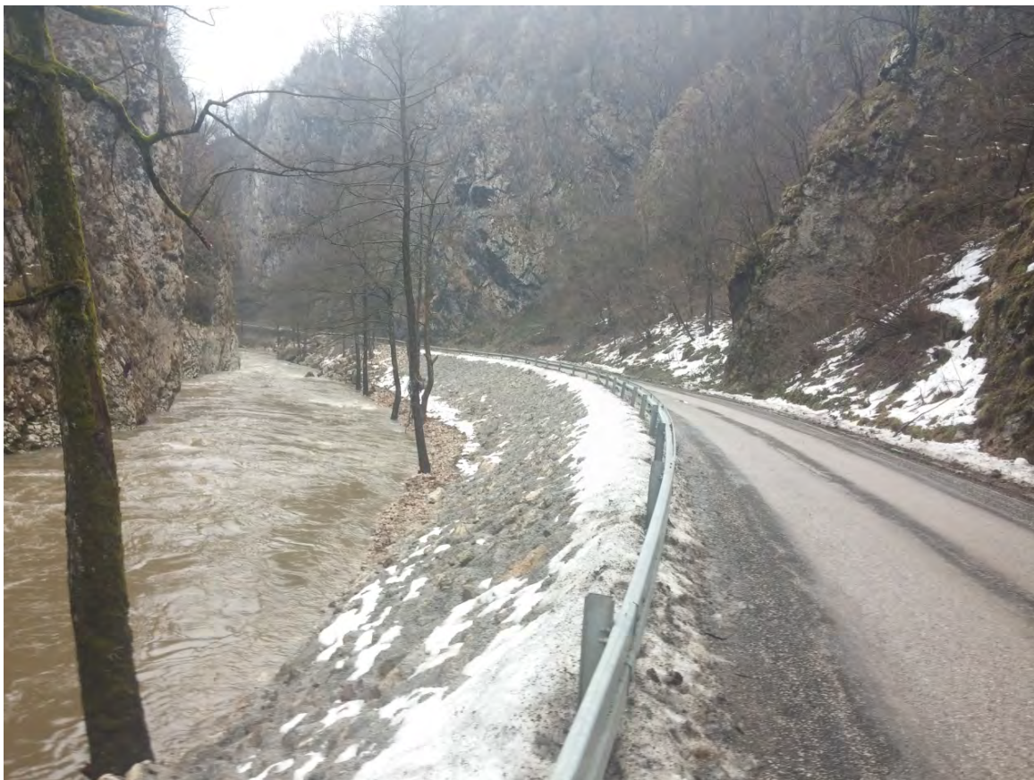
Slika broj: 56. Urađena obaloutvrda kao zaštita trupa ceste
