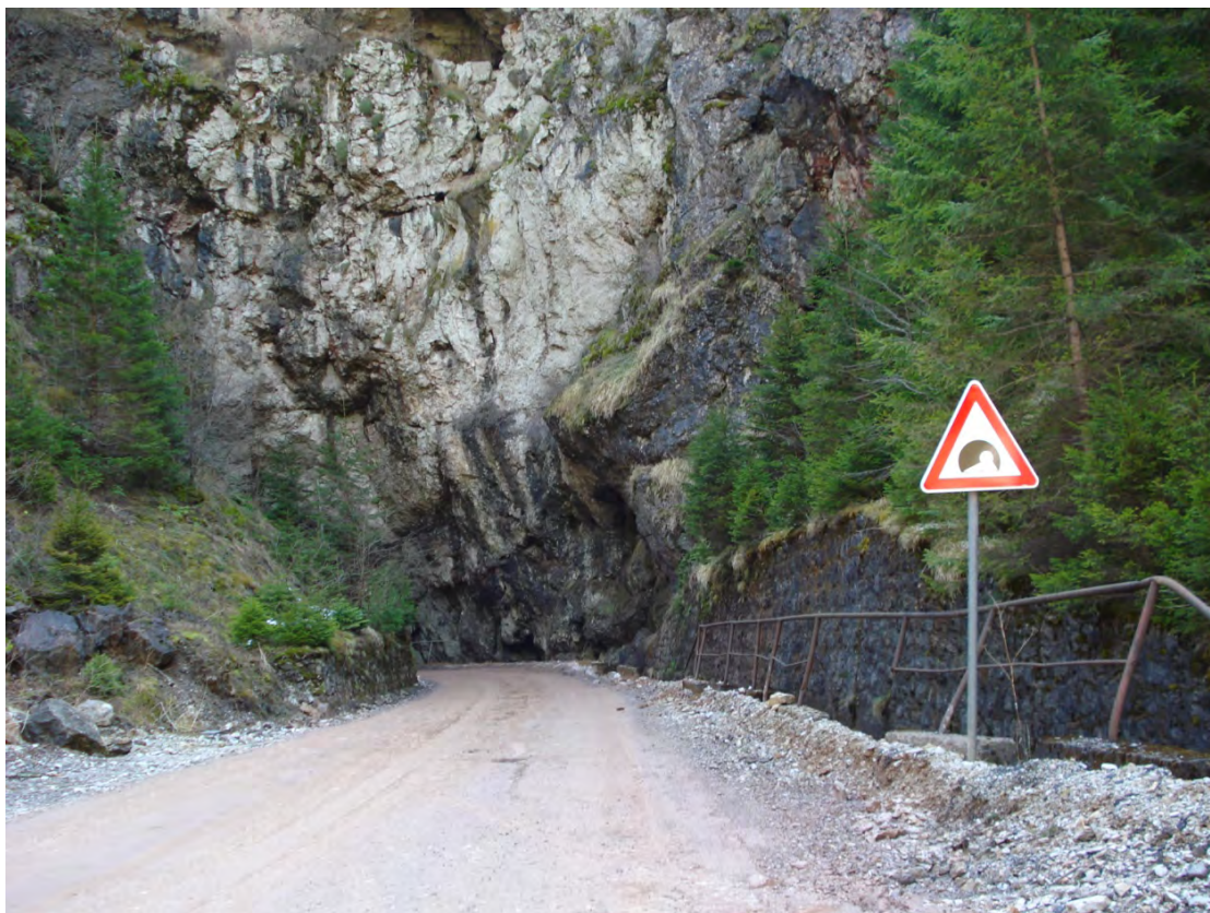
Slika broj: 18. Saobraćajnica pred ulaz u tunel „Ponikva“
