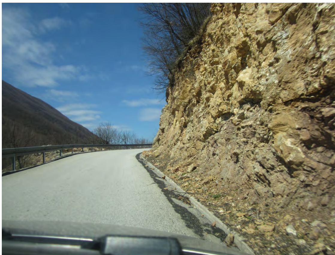
Slika broj: 47. Rekonstruisana dionica ceste
