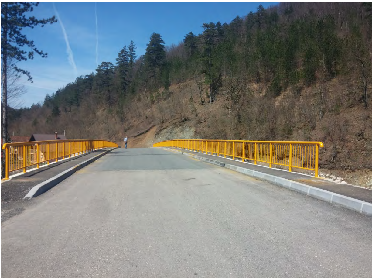
Slika broj: 55. novoizgrađeni most „Podkamensko“
