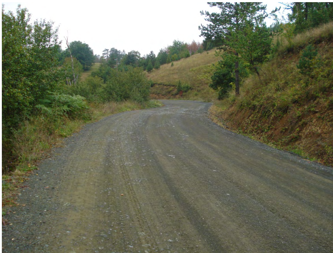
Slika broj: 20. Makadamski kolovoz na dionici Šimin Potok-Podkamensko
