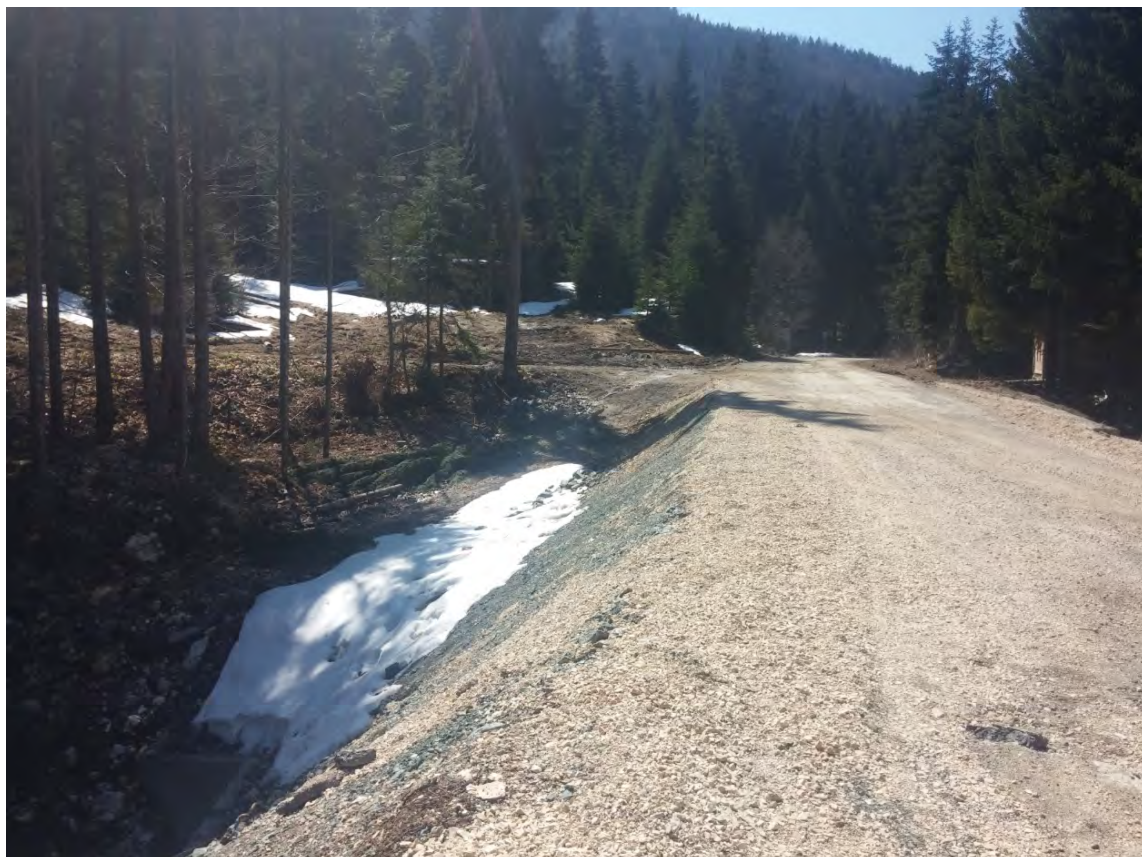
Slika broj: 59. Sanirano klizište Olovo - Han Pijesak
