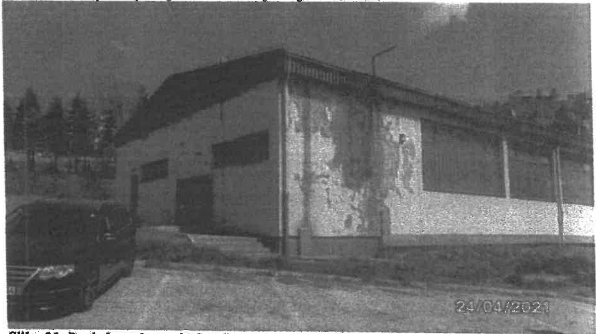
Slika 21. Pogled na ulaz u objekat Centralna praonica
