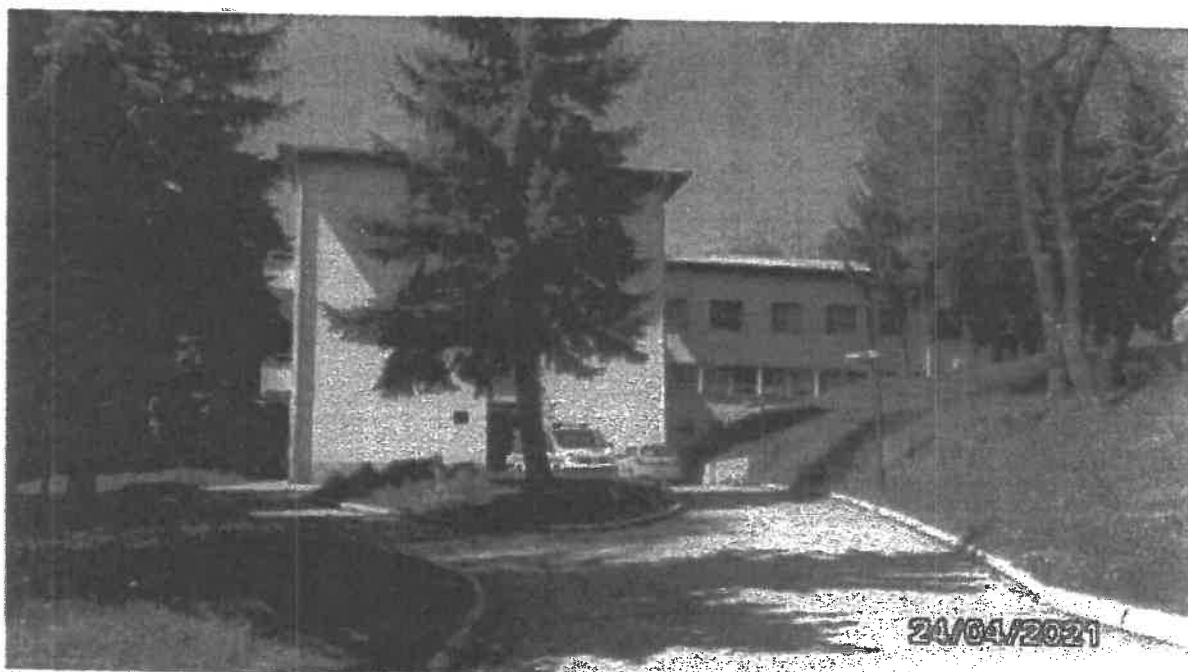
Slika 24. Pogled na objekte zarazno i za laboratoriju
