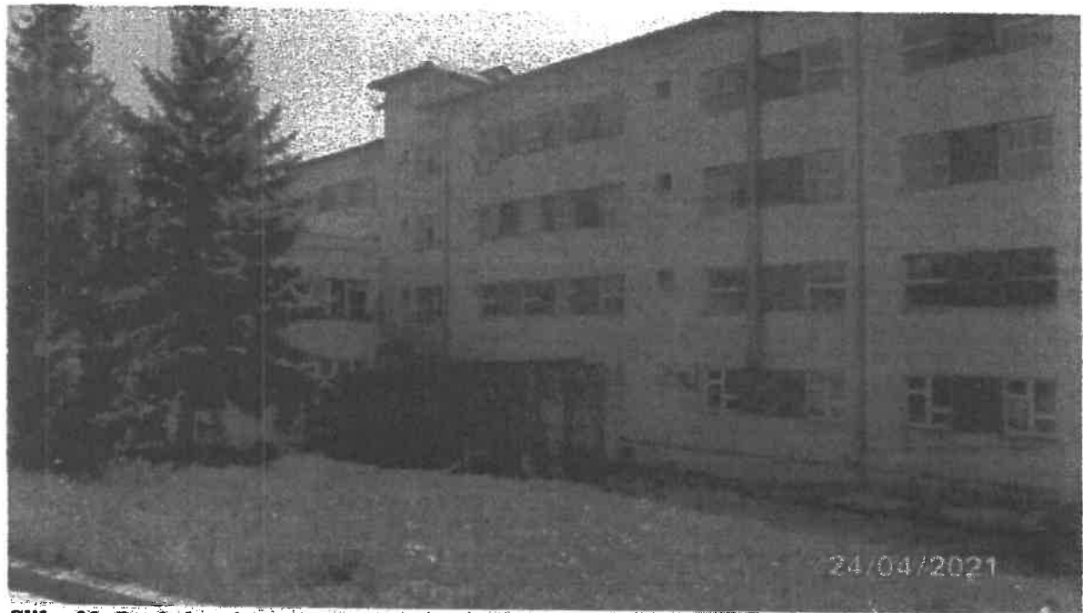
Slika 32. Pogled na lijevo krilo internog sa dograđenom nadstrešnicom pored objekta
