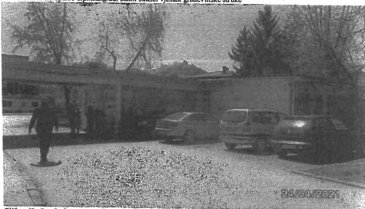
Slika 49. Pogled na izgrađene objekte uz ulaznu kapiju
