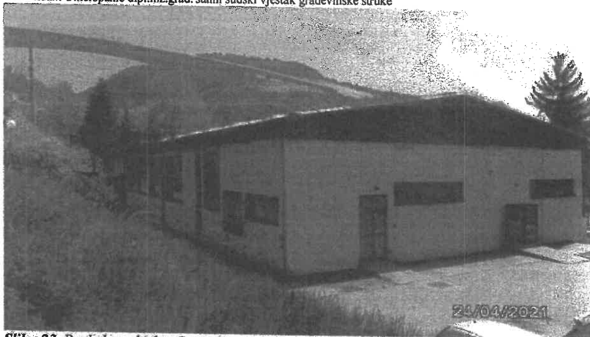
Slika 23. Pogled na objekat Centralna praočica sa sjeverne strane
