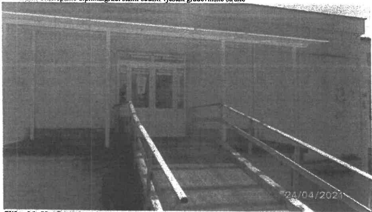
Slika 31. Urađena druga pasarela za ulaz
