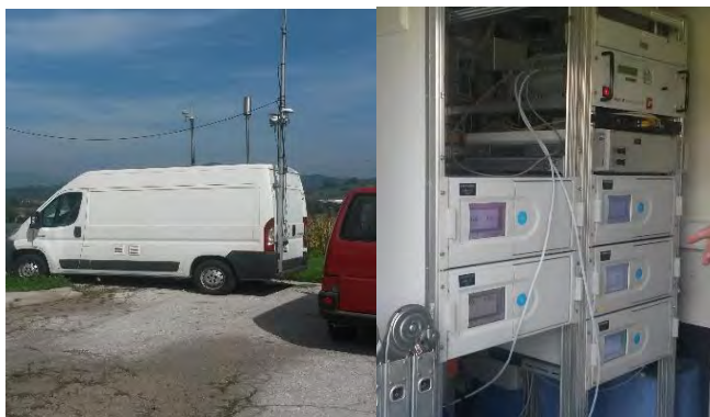
Slika 15. Mobilna automatska stanica za monitoring kvaliteta zraka
